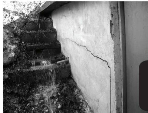
Водата застрашава състоянието и на без това напуканата сграда
