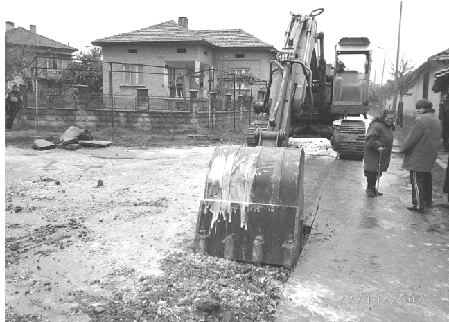
Първата строителна машина започна своята работа
