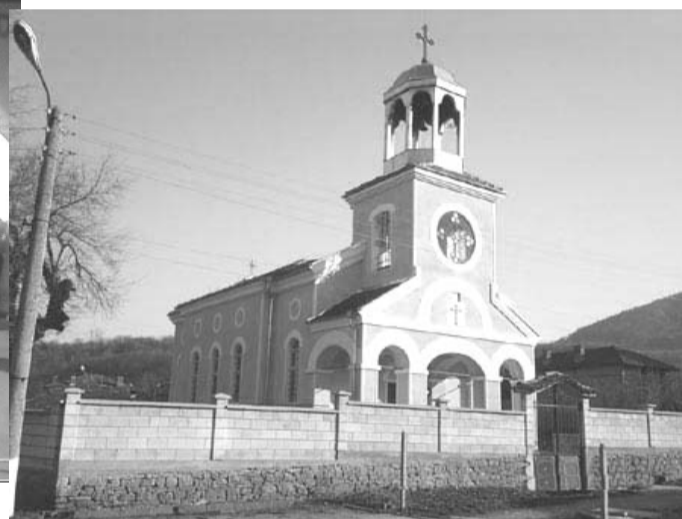
Ремонтираният православен храм в село Бял брег
