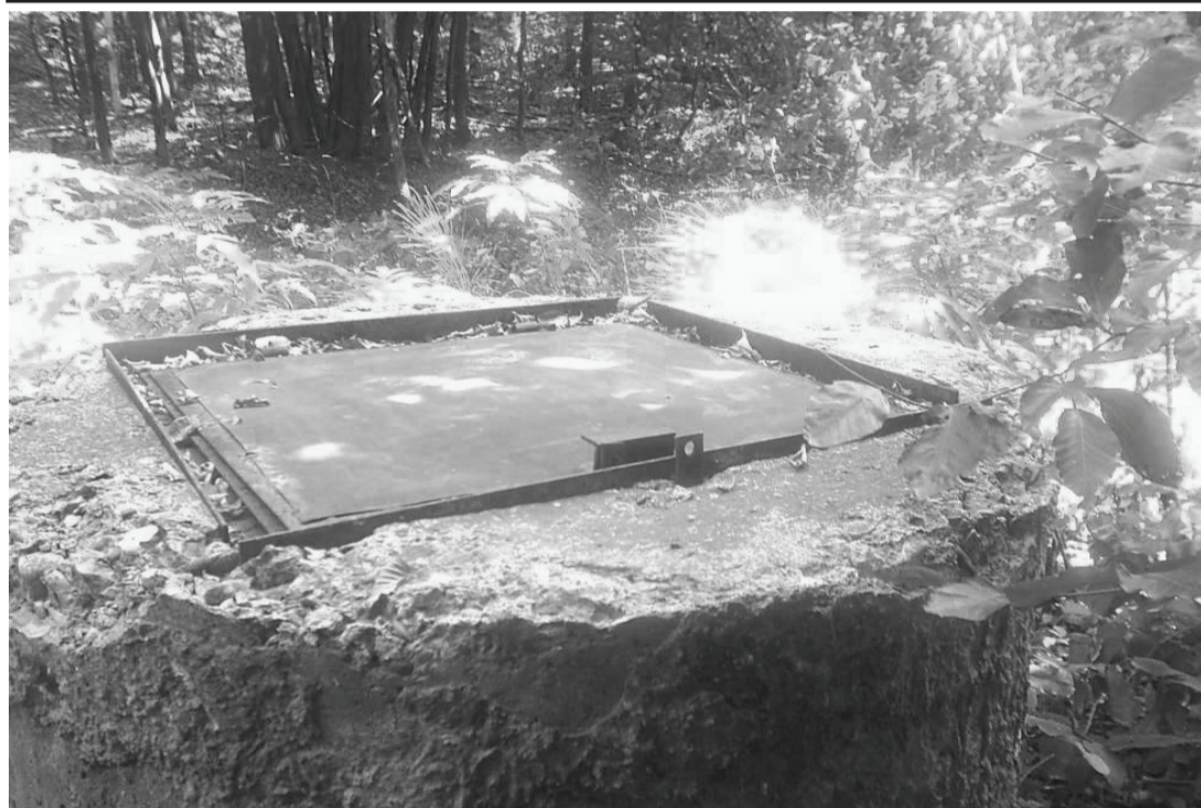
НА ТОЗИ КАПТАЖ Е ВИДНО, ЧЕ ЛИПСА КАТИНАРА ЗА ЗАКЛЮЧВАНЕ НА МЕТАЛНИЯ КАПАК
