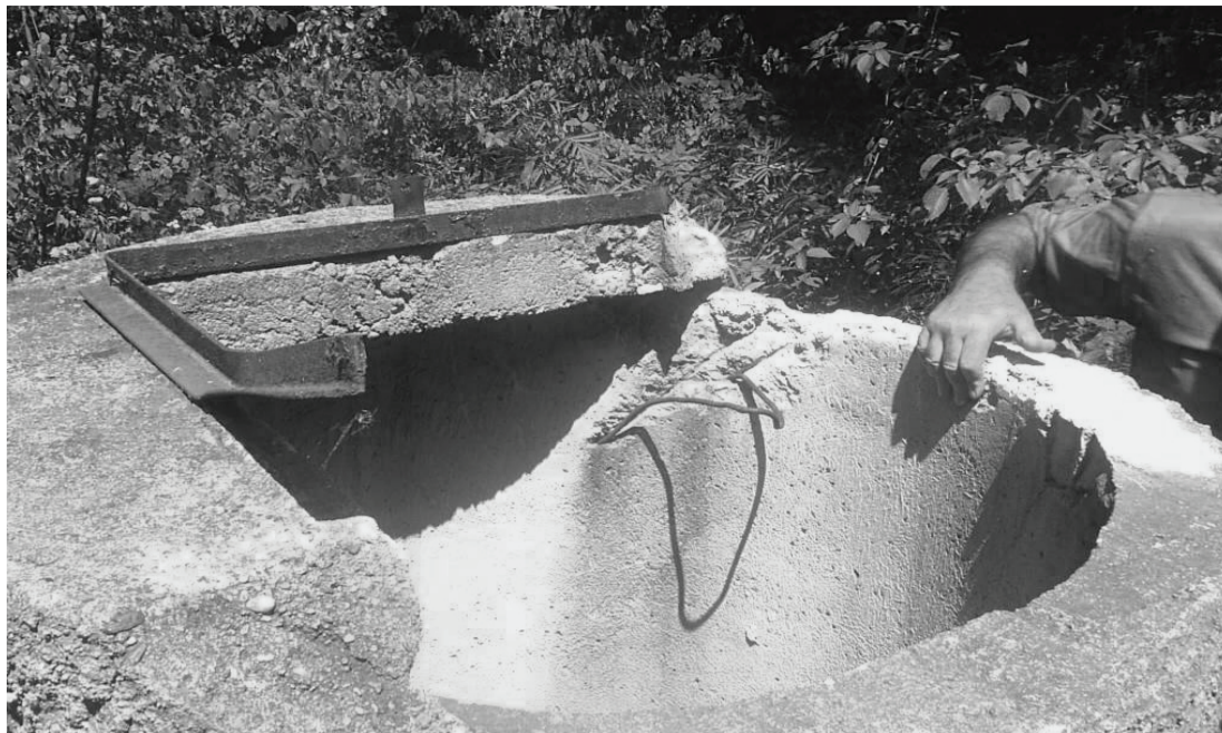
КАПТАЖ “ КАДАФИНИ” С ЛИПСАЩ КАПАК И МЕТАЛНА СТЬЛБА
