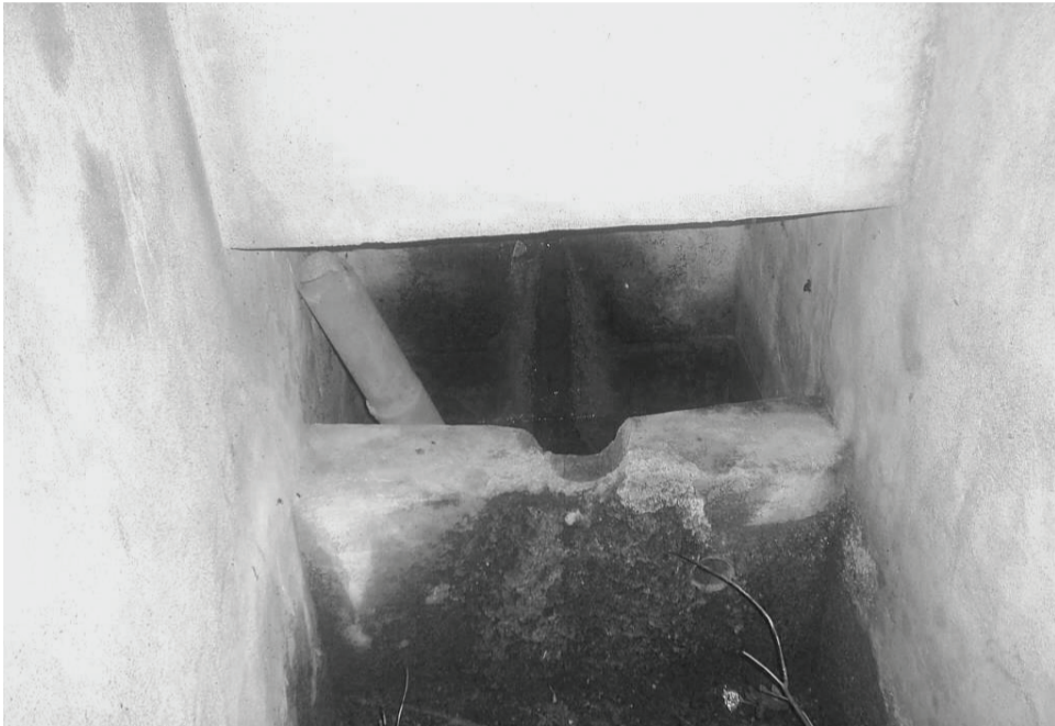
Каптаж "Градището"-няма вода, разбит тръбопровод и липса на метална врата
